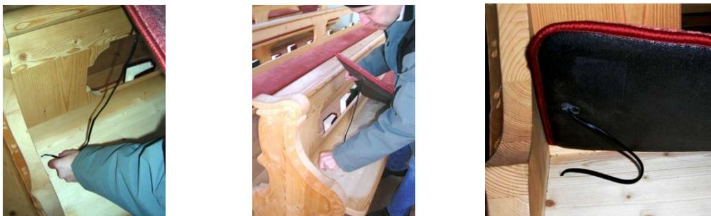
Abb.3 angehobenes Polster mit ersichtlicher Schlaufe
